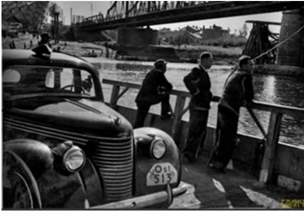
Побудова першого моста через р. Дністер у Галичі Фото з відкритих джерел
