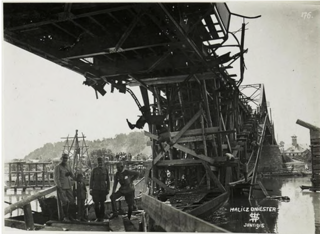
Пошкоджений залізний міст через р. Дністер. Галич, червень 1915 р. Фото з відкритих джерел
